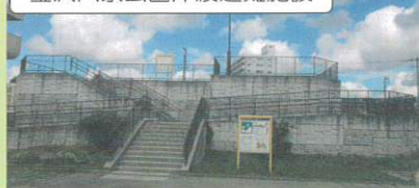
金沢八景公園津波避難施設
